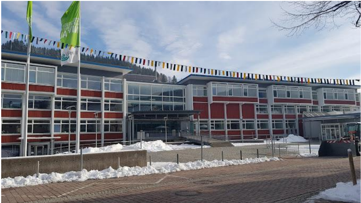
A HFU főépülete, az „A” épület
